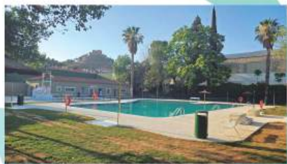
Readecuación de la piscina municipal
