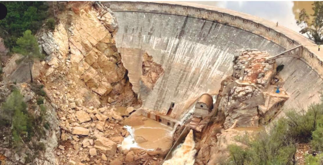
Desde la devastadora DANA del 29 de octubre, se lleva un intenso seguimiento de la presa de Buseo de Chera que, en el momento de máxima crecida, se estima que la lámina de agua se situó entre 2 y 2,5 metros por encima de la coronación de la misma, produciendo **daños en distintos elementos de esta infraestructura hidráulica.**
