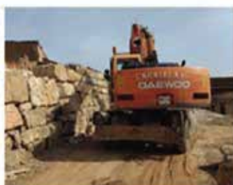
MINIMIZACIÓN DE RIESGOS GEOLÓGICOS MEDIANTE MURO DE ESCOLLERA EN TITAGUAS
