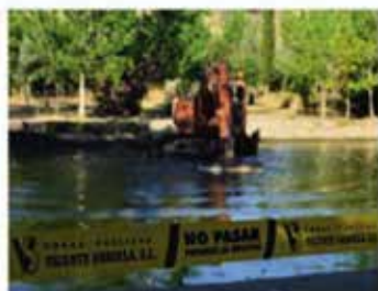
LIMPIEZA Y ADECUACIÓN DE LA PLAYA "EL MOTOR" EN EL RÍO TÚRIA EN GESTALGAR
